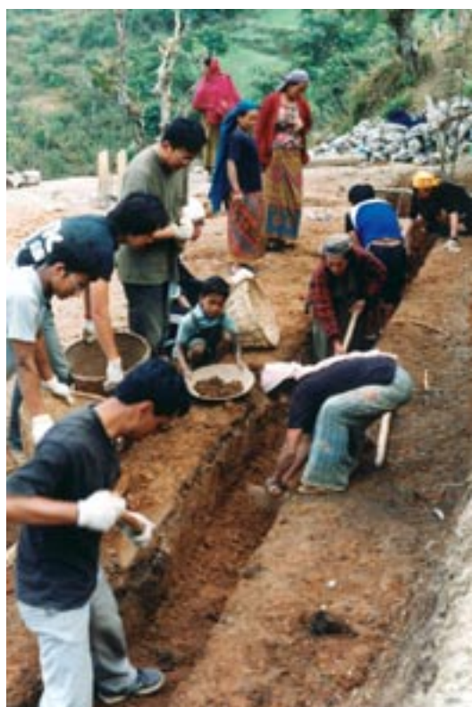
村民総出の溝掘り
